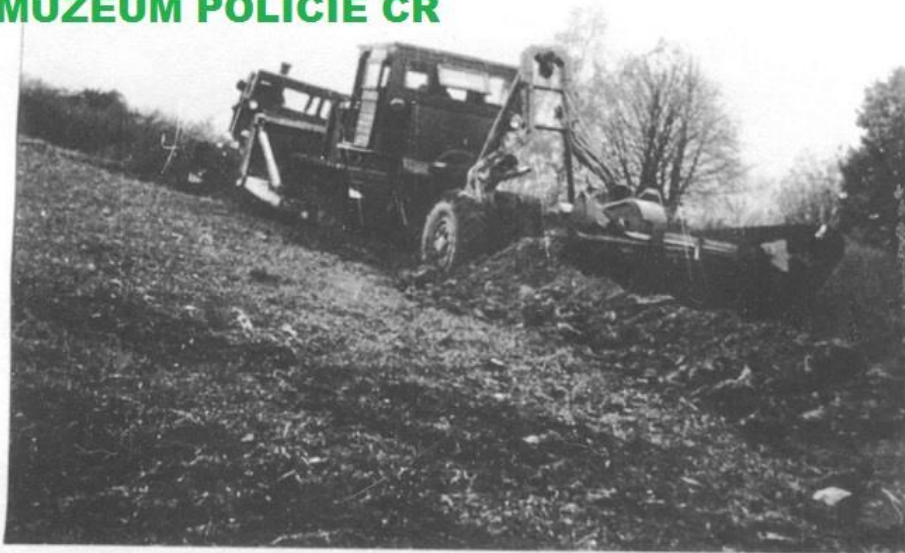
b/ Důležitou součástí zajištění úseků proti násilnému přejezdu vozidel přes trasu signalizační zabezpečovací soustavy jsou překopy.
